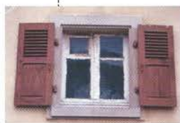
Portes et fenêtres avec leurs encadrements en pierre taillée
