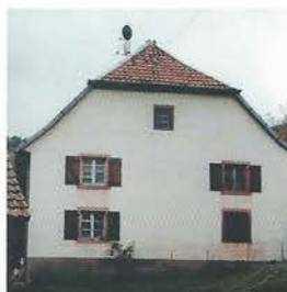
Toiture à croupe
