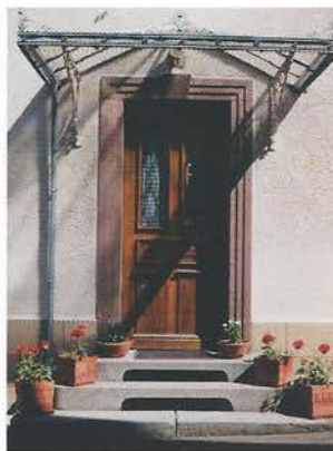
Portes et fenêtres avec leurs encadrements en pierre taillée
